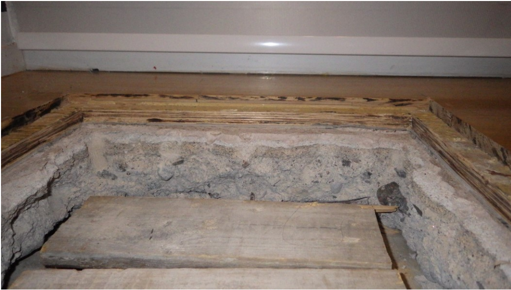
Kuva 9. Joskus on saatettu säilyttää kaikki eri-ikäiset pintamateriaalit paikoillaan, kuten tässä 1930-luvulta peräisin olevassa rakennuksessa. Kuntotutkimuksen aikana tehtiin rakenneavaus lattiaan, josta paljastui eri-ikäisiä pintakerroksia. Vanhin lattiapinta on ollut asbestipitoista magnesiamaassaa, jonka päälle on liimattu asbestipitoisella liimalla kvartsivinyyli-laatoitus. Näiden päälle on asennettu vaneri ja parketti. Rakenneavaus tehtiin asbestipurkuna, kun havaittiin, että rakenteissa on asbestia. Kuva AFRY Finland Oy.
