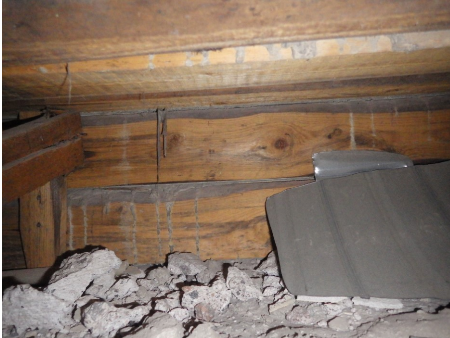
Kuva 18. Kuva rakennuksen välipohjan hyväkuntoisista muottilautoista, joita ei ole tarpeen poistaa rakenteesta, mutta joiden olemassaolo tulee huomioida korjauksissa. On huolehdittava siitä, että laudat eivät kastu jatkossakaan. Kuva AFRY Finland Oy.
