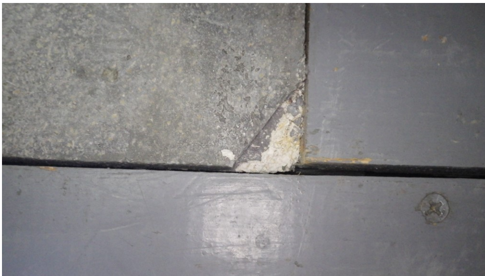
Bild 3. Enligt användarna fanns det "cementgolv" i ett utrymme, men i konditionsundersökningarna av byggnaden upptäckte konditionsundersökarna att materialet var magnesiummassa med asbest. Massan kunde identifieras av det nedre vita "lagerskiktet" och asbesthalten säkerställdes genom analys. Bild AFRY Finland Oy.
