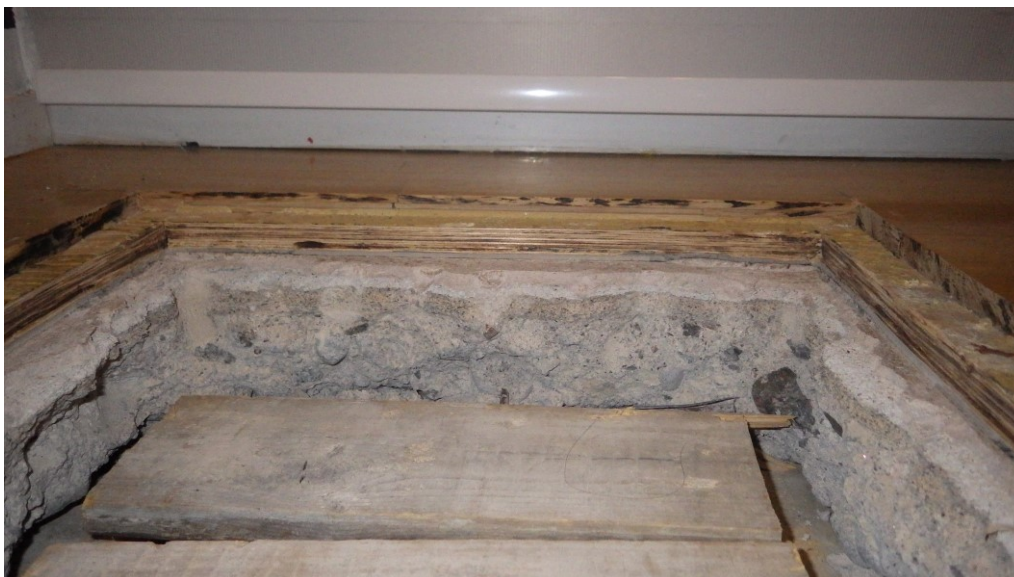
Bild 9. Ibland har man bevarat alla ytmaterial i olika åldrar på sina platser, såsom i denna byggnad från 1930-talet. Under konditionsundersökningen gjordes en öppning i golvet som avslöjade ytskikt i olika åldrar. Den äldsta golvytan har varit asbesthaltig magnesiamaassa, på vilken man har limmat kvartsvinylplattor med asbesthaltigt lim. Ovanpå dessa har man installerat faner och parkett. Konstruktionsöppningen gjordes som asbestrivning när man observerade att det fanns asbest i konstruktionerna. Bild AFRY Finland Oy.
