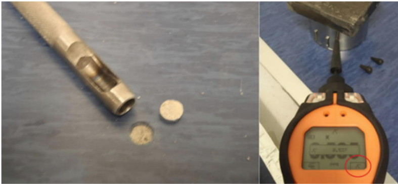
Kuva 29. Vasemmalla PID-näytteenottokohdan avaaminen ja oikealla mittaus käynnissä (Muovipäälysteisten lattioiden vaurioituminen kosteuden vaikutuksesta. Tampereen Yliopisto, Rakennustekniikka 2021).
