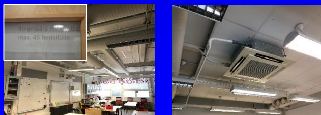
Ilmanvaihdon on oltava riittävä ja ilmavirtojen oltava tasapainossa
