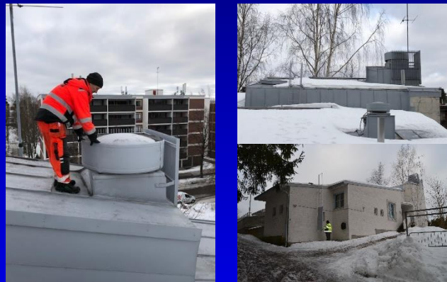
Ulkoilmalaitteet ja erillispoistot tarkastetaan yleensä vesikatolla
