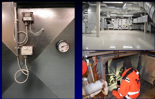
IV-konehuoneen tulee olla puhdas ja IV-koneiden huollettuja
