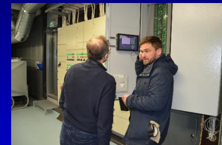
Ilmanvaihtoa ohjaavan automaation toiminta voidaan tarkastaa etäyhteydellä ennen kohdekierrosta
