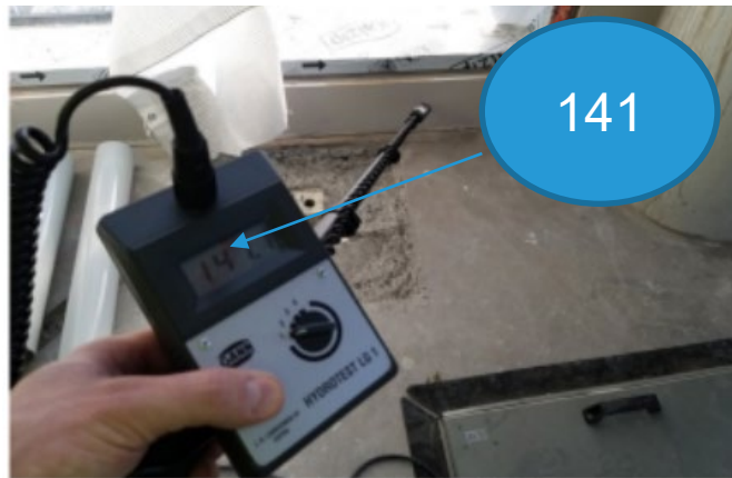
Levyrakenteesta mitattiin korkeita pintakosteuslukemia vaurioalueelta.
