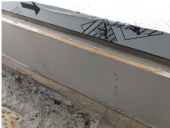
Kipsilevyrakenteessa vaurioita ikkunan alla.
